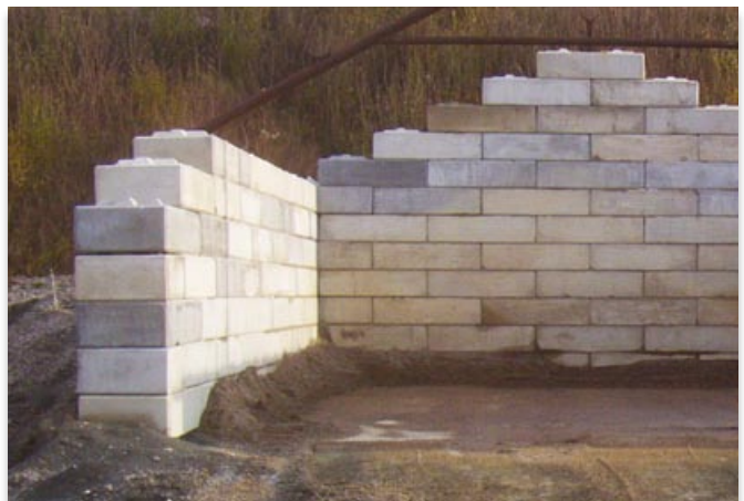
Jederzeit versetzbar durch geeignete Hebezeuge mittels 2 eingegossene Seilhülsen Rd. 16
